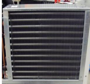
Le alette dello scambiatore sono molto delicate, porre particolare attenzione durante le operazioni di pulizia per evitare di piegare le alette
